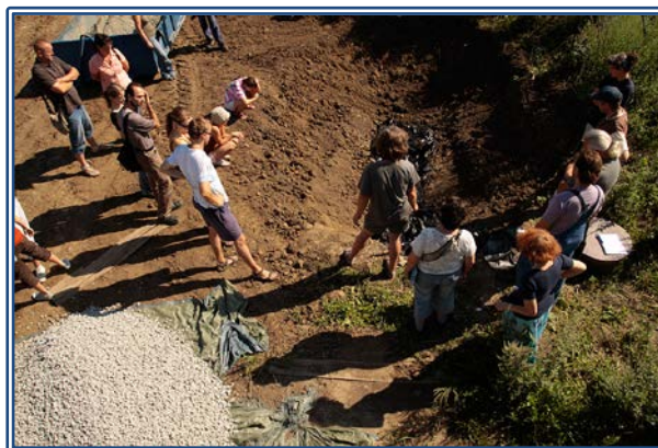
és a biofilter építése
